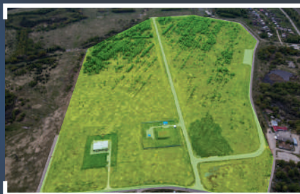
快速接入工程基础设施
